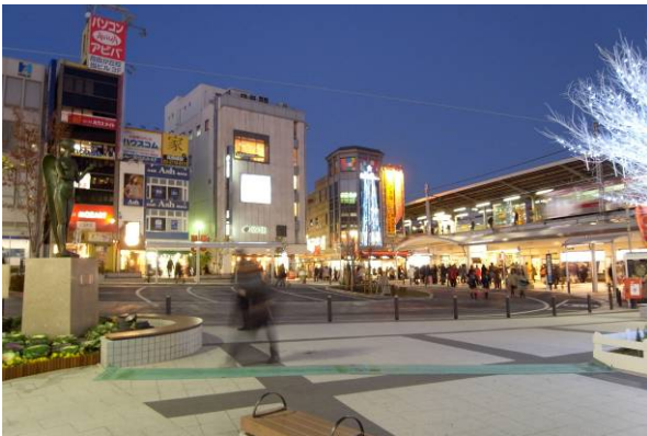
歩行空間を広げてパリアフリー化をはかった駅前広場。シンボルである女神像は移設し、広場内に設置している。
